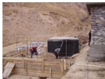
Строительство водного резервуара, село Дашти Майдон
